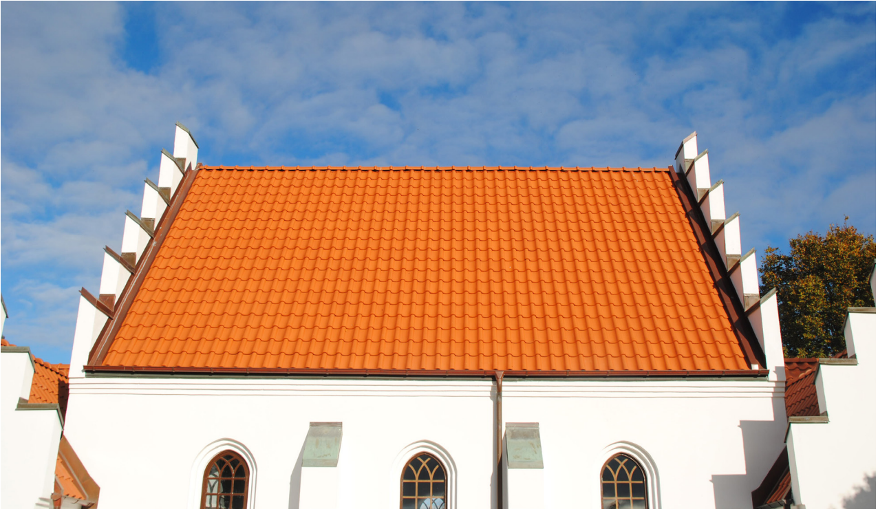
Skeppets tak efter omläggning med nya lertegelpannor.
