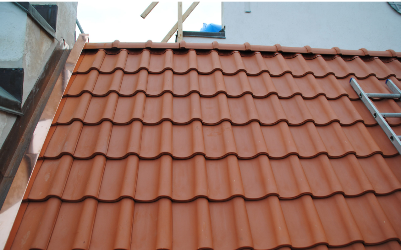
Taket är lagt med lertegelpannor från Monier, modell Hollander obehandlad röd. Undernockpannorna har ett tegelrött nockband monterats.
