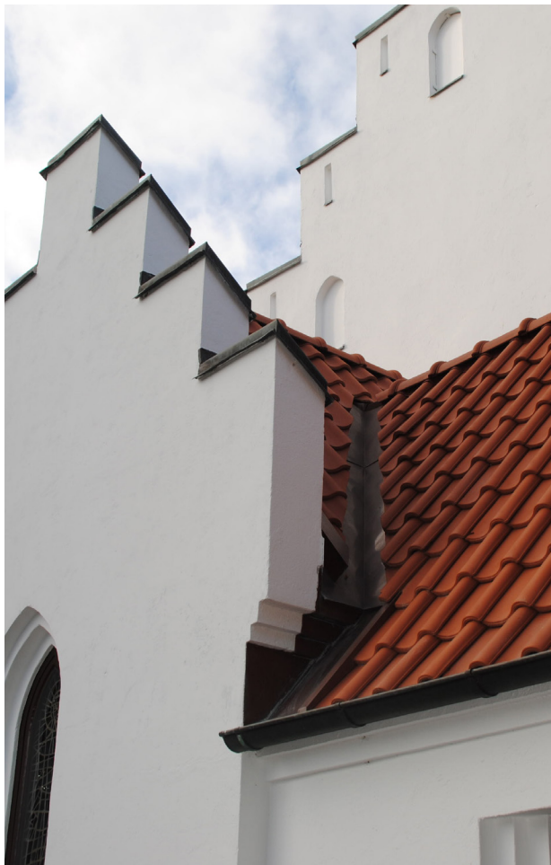
Avtäckningar på trappstegsgavlarnas murkrön har rättats till och fästs fast. Putskanter har förbättrats.
