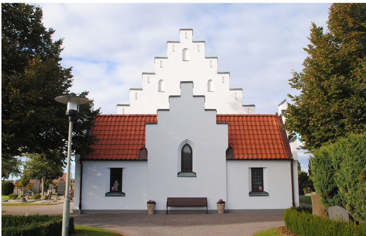
Fasaderna mot söder och öster efter renoveringen.
