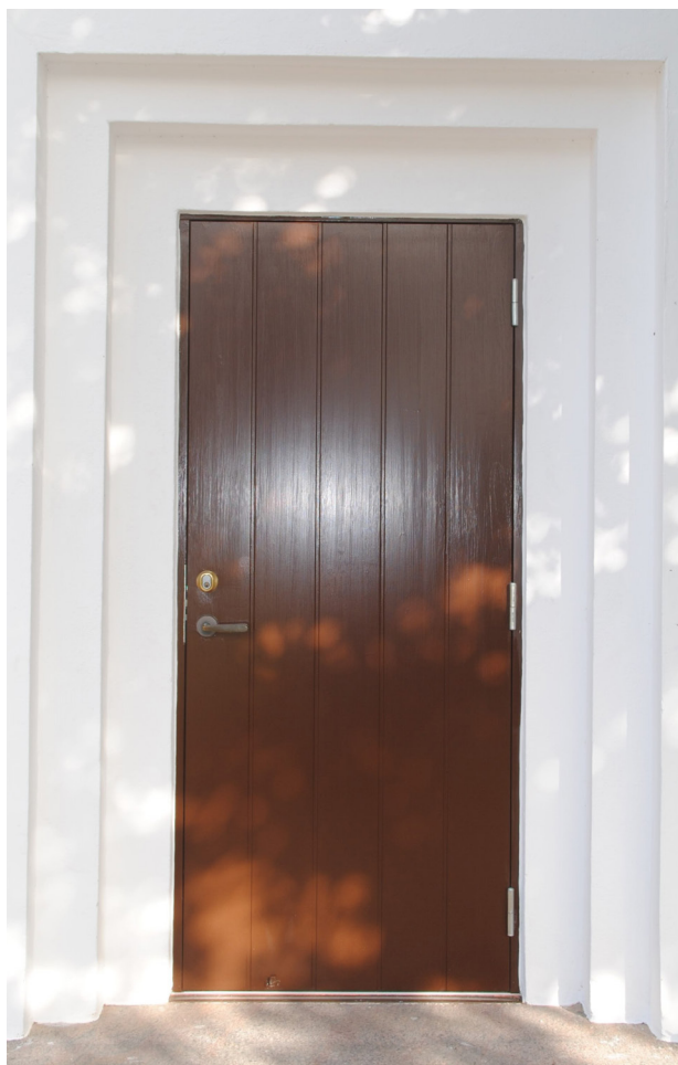
Den nya dörren till sakristian, platsmålad med linoljefärg i samma kulör som entrédörren i väster.
