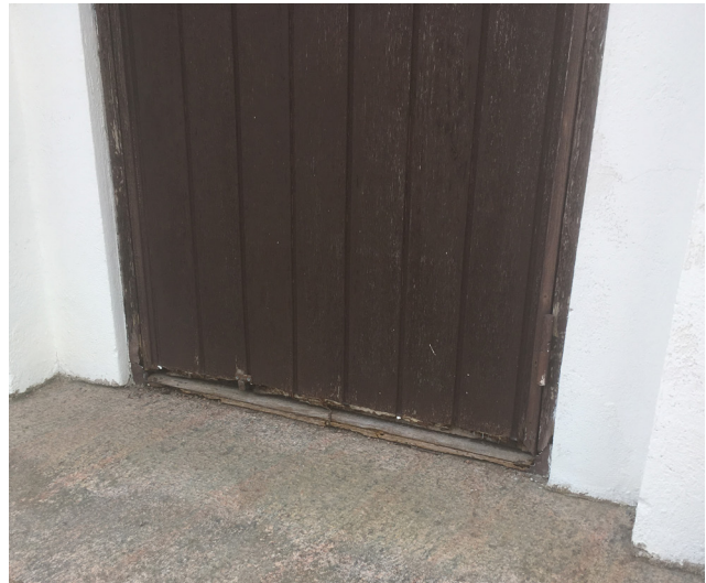
Dörren till sakristian var i dåligt skick. Den hade stora rötskador i bottenstycket och på nedtill på panelskivan.
