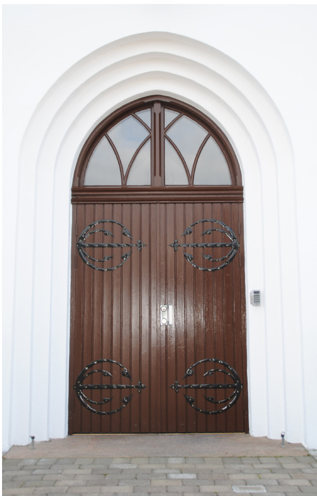
Entrédörren med överljus i väster efter renovering.
