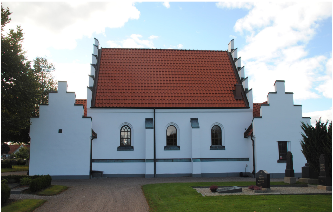
Fasaderna mot väster och norr efter renoveringen.
