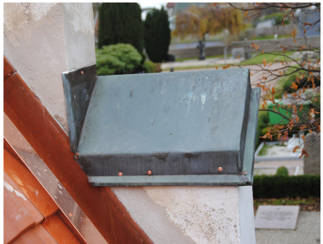
Avtäckningar på trappstegsgavlarnas murkrön har rättats till och fästs fast. Putskanter har förbättrats.
