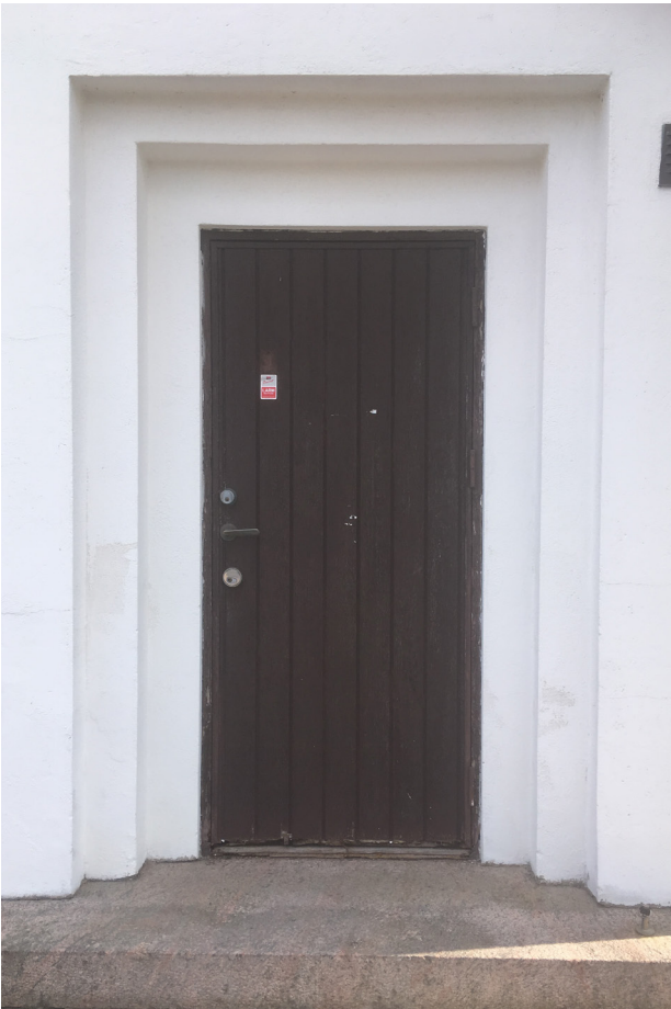
Dörren till sakristian var i dåligt skick. Den hade stora rötskador i bottenstycket och på nedtill på panelskivan.
